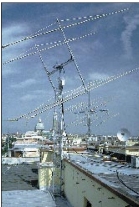
Auf dem Dach bei IW5AVM in Grosseto. Im Vordergrund die 9,15 m langen Shark-Larets für 2 m, im Hintergrund die 16er-Gruppe für 70 cm. Fotos: I4YNO
