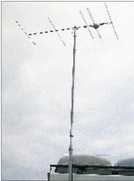
Bild 4: 5-Element-Kurz-Yagi (Typ 1) mit Faltdipol als Strahler
